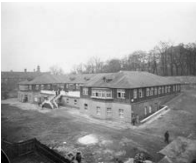
Celkový pohled na studentský domov na Albertově na Novém Městě, kolem roku 1905. (foto: Tomáš Vojsa)
